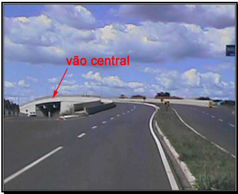
Fig.6.8 – Vista Geral da Obra
