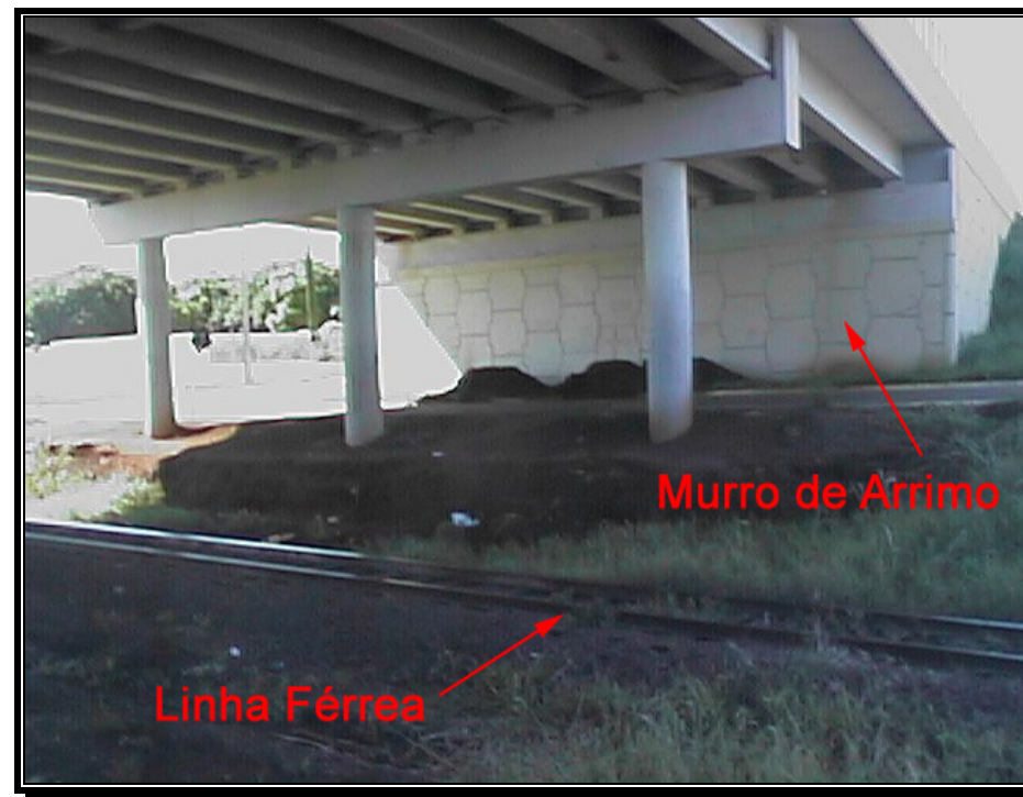
Fig. 6.9 – Vista Inferior do Viaduto
